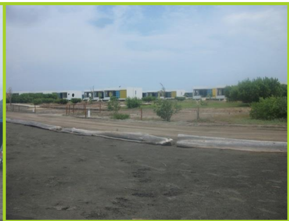
Impermeabilización del suelo
